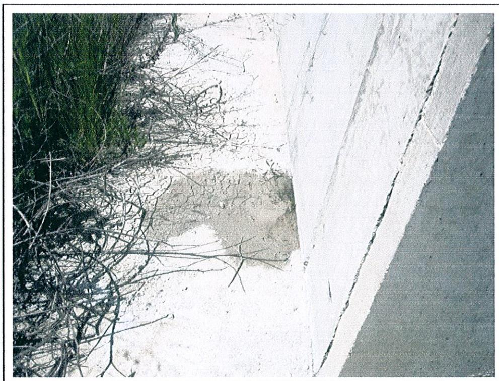
**Foto n.14** – Emergenza di acqua alla base del muro -
